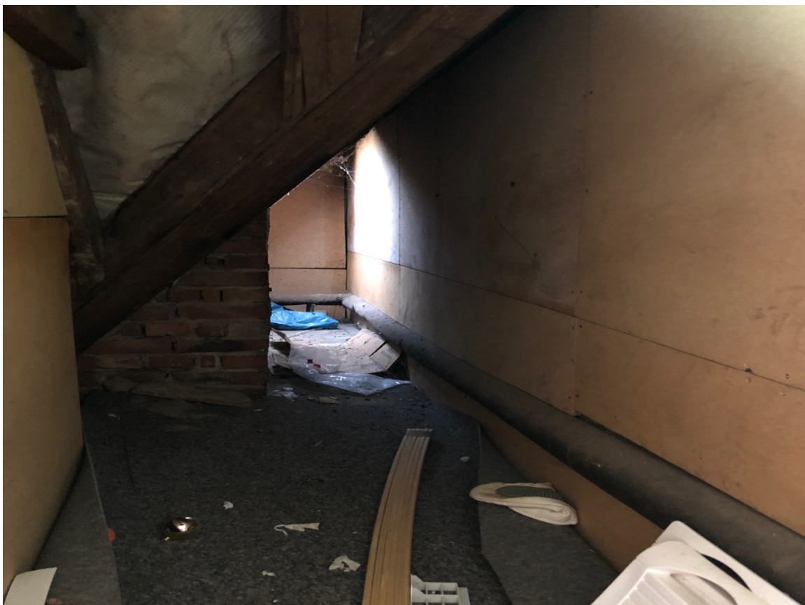
Abb. 9: Dachboden des Wohngebäudes Hildtstraße 7.
