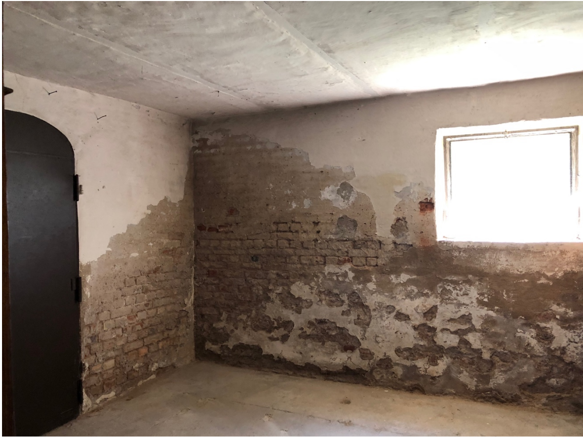
Abb. 10: Kellergeschoss des Wohngebäudes Hildtstraße 7.
