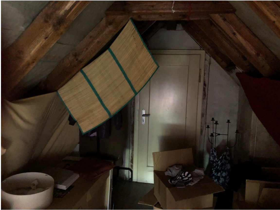
Abb. 4: Dachboden des Wohngebäudes Lenastraße 2.
