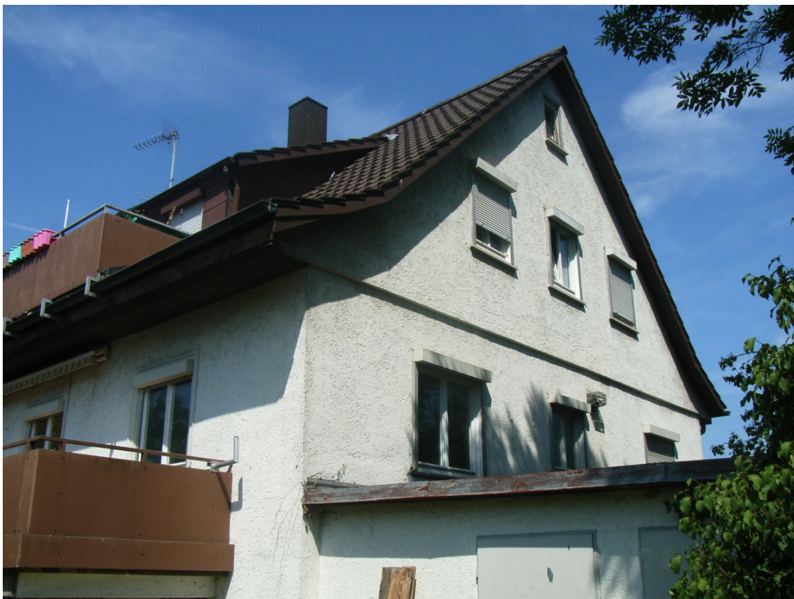
Abb. 3: Außenfassaden und Dachbereiche des Wohngebäudes Lenastraße 2.
